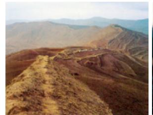
秦长城遗迹 秦始皇时的长城比现在的长城更靠北,大都是土筑的,个别也有石筑的。这 段在今内蒙包头市固阳县的秦长城,以石筑砌,至今仍然保存完好。
